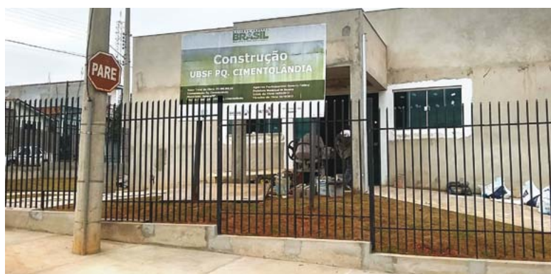
A UBS do Parque Cimentolândia está em fase de finalização
