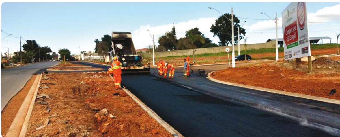
Serviços de pavimentação estão sendo realizados na Avenida Gastão Mesquita Filho
