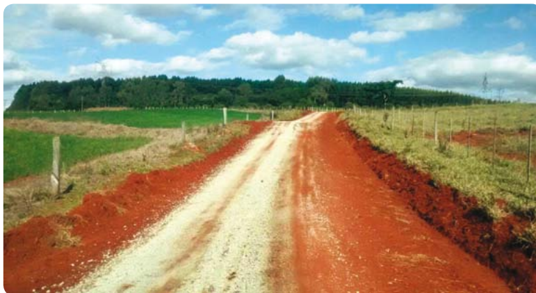
Estrada rural no Bairro de Cima, que dá acesso à estrada vicinal Esperidião Lúcio Martins
