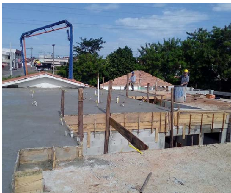
Construção da laje da UBS São Camilo
