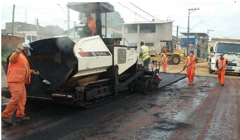
Asfaltamento da Rua Estelita Ribas no Parque Cimentolândia
