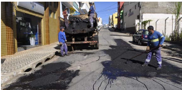
Operações tapa-buracos foram feitas na área central do município
