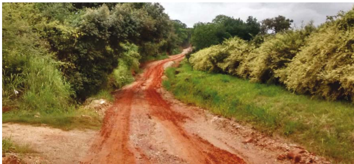
Estrada do bairro do Jaó recebe os serviços de cascalhamento e colocação de pedras
