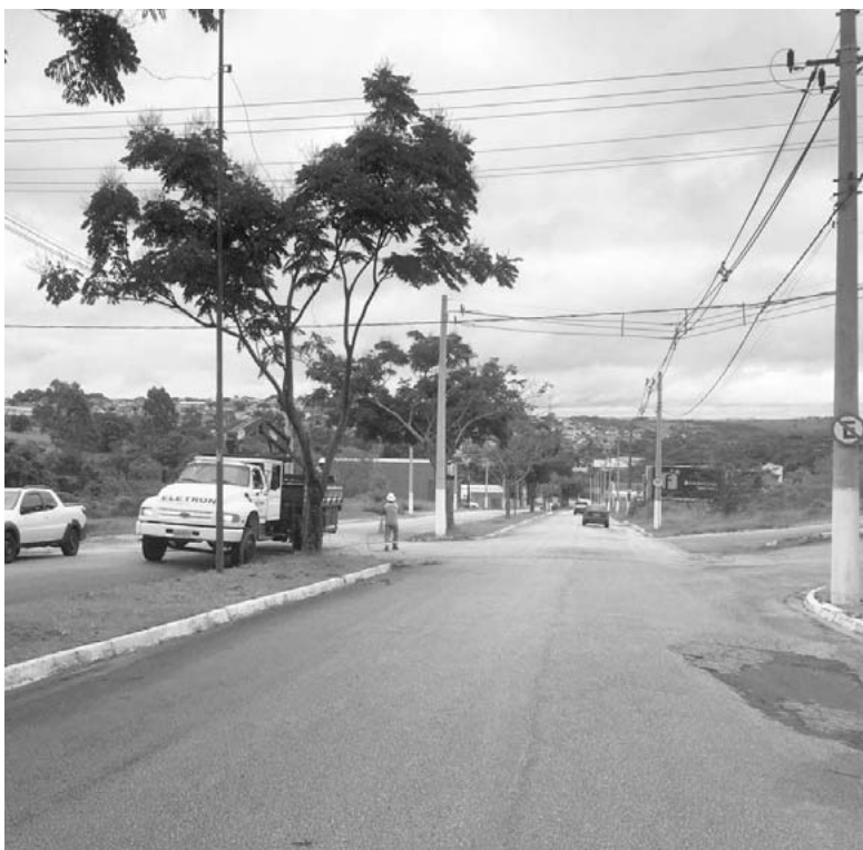
Serviços de iluminação pública estão sendo realizados na cidade
