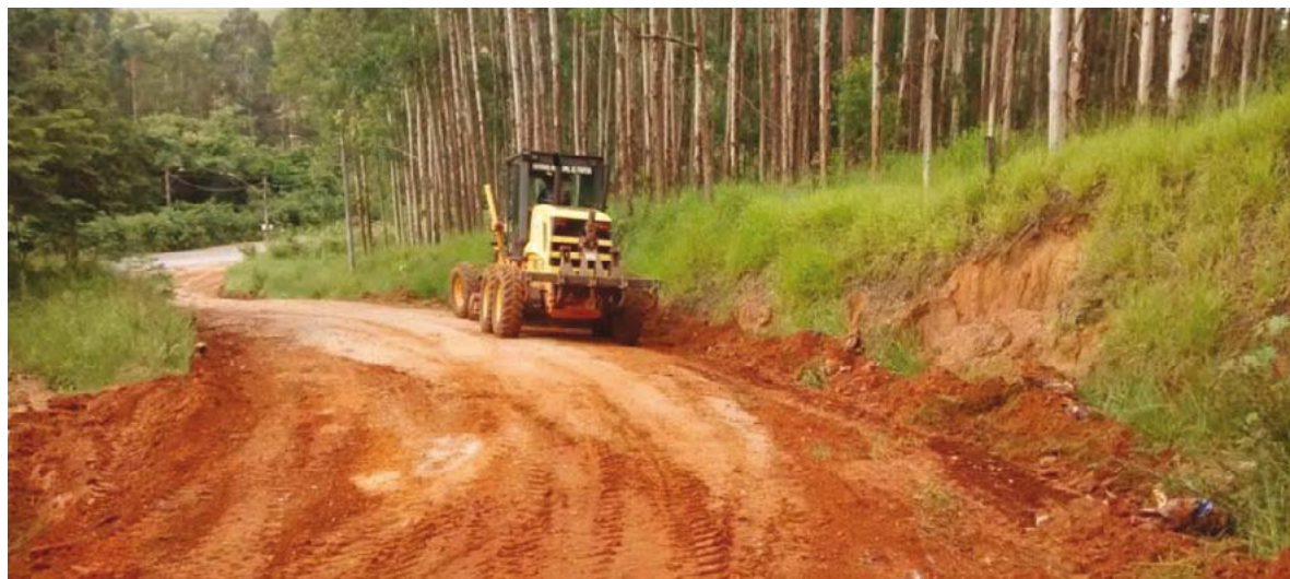
Estrada que dá acesso à Apae na Vila Maringá
