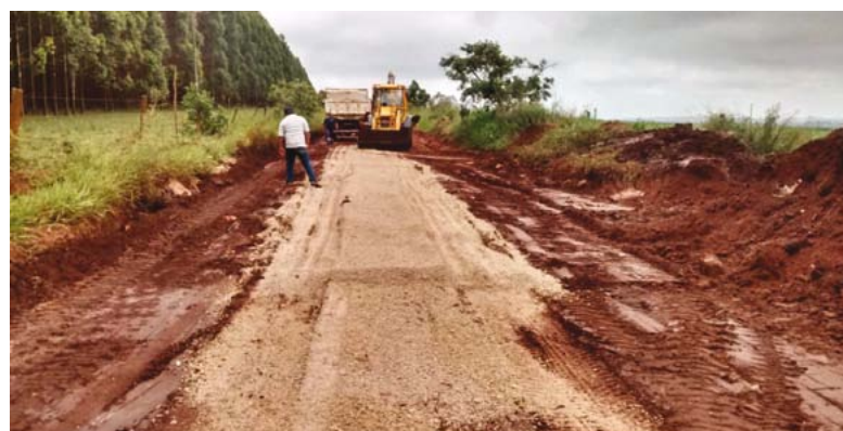
Máquina trabalha na recuperação da estrada rural que liga o Bairro do Leme ao Distrito da Caputera
