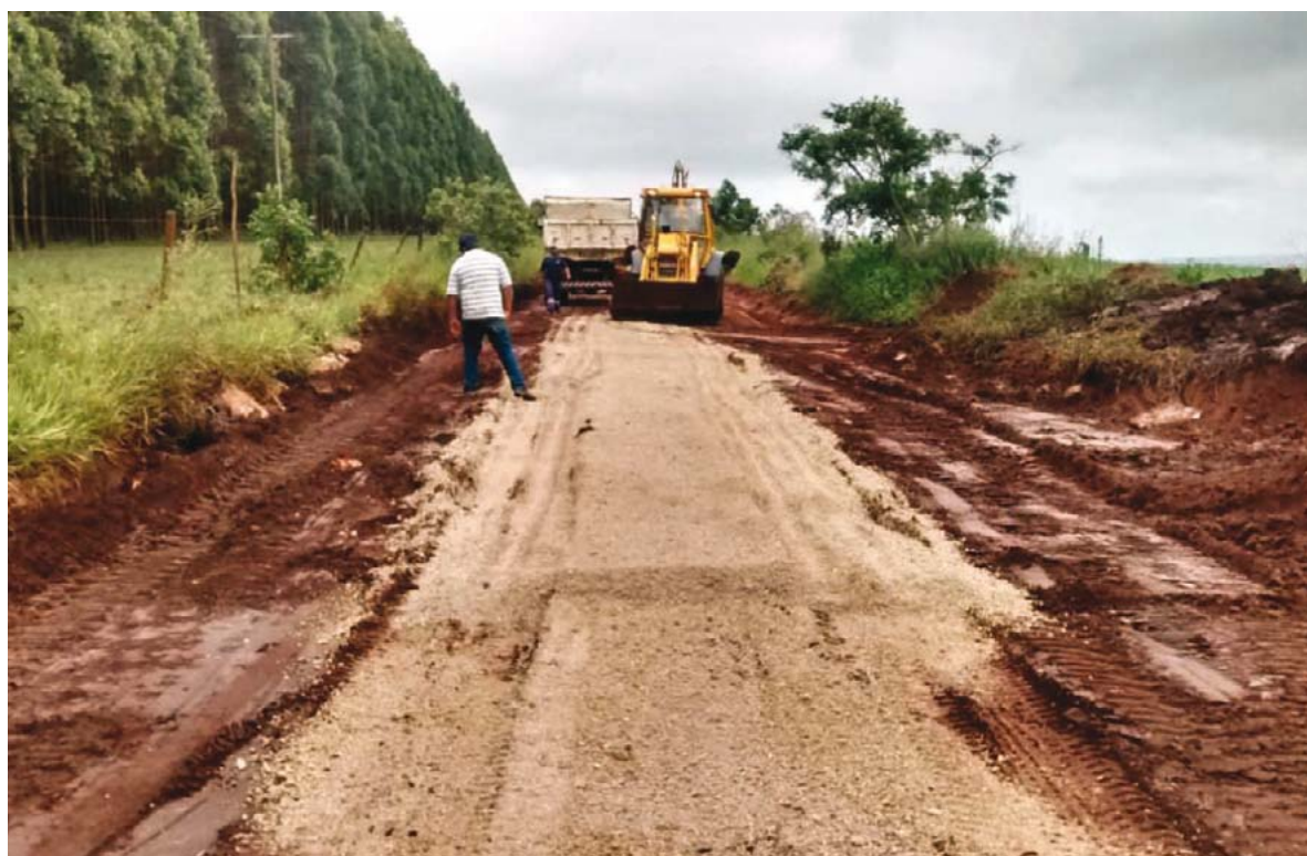
Máquina trabalha na recuperação da estrada rural que liga o Bairro do Leme ao Caputera
