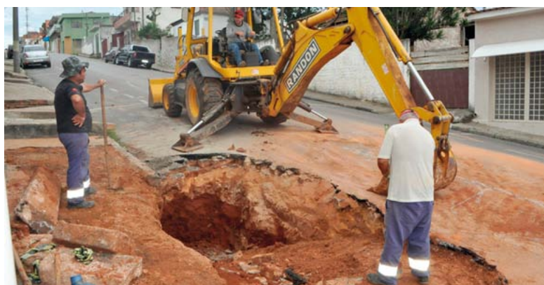
Servidores realizam manutenção de galerias pluviais na rua Barão do Rio Branco, na Vila Nova
