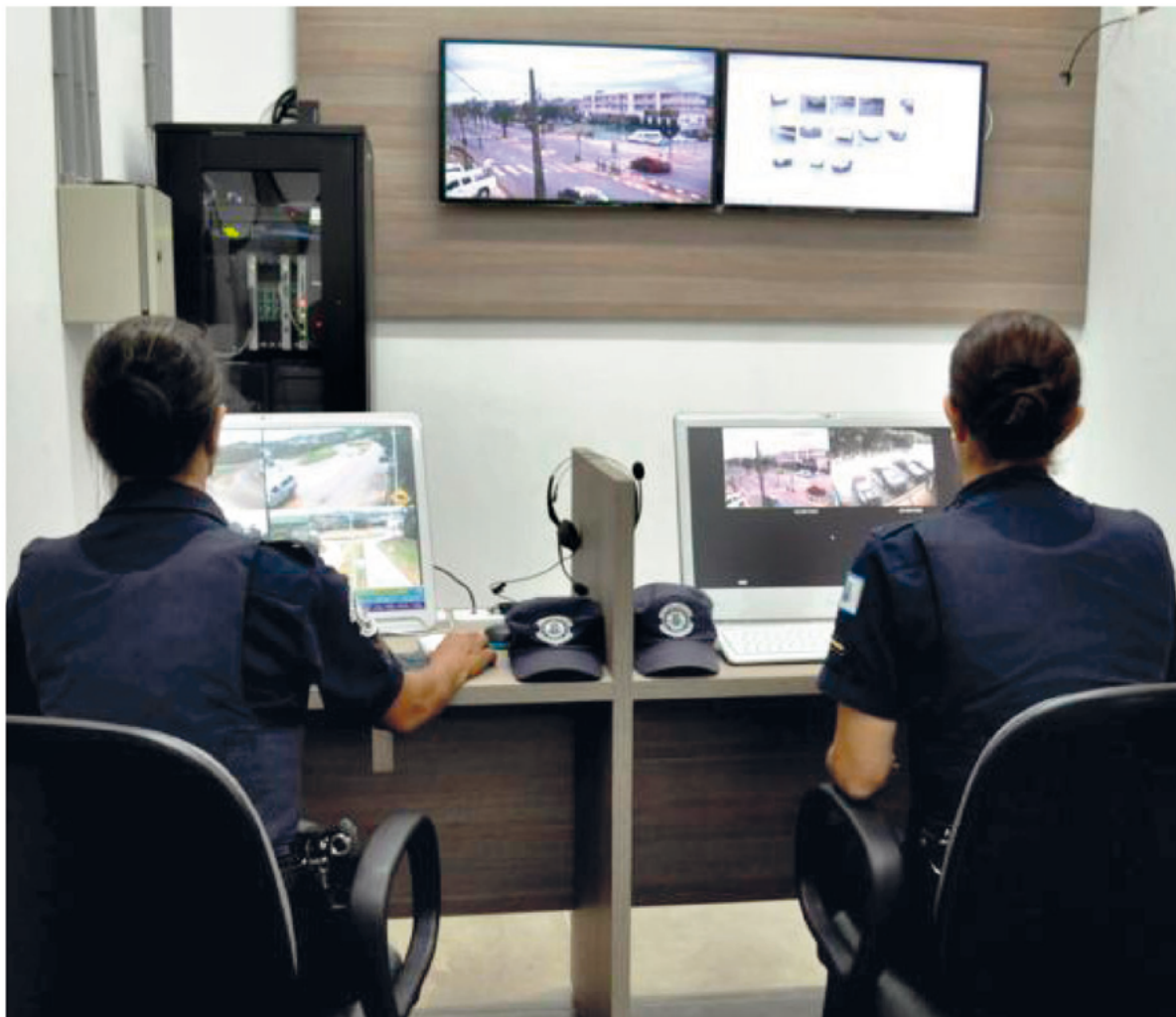
As câmeras de segurança fornecerão imagens em tempo real para o Centro Integrado de Monitoramento e Atendimento de Emergência de Itapeva
