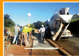
Profissionais na construção de Itapeva
