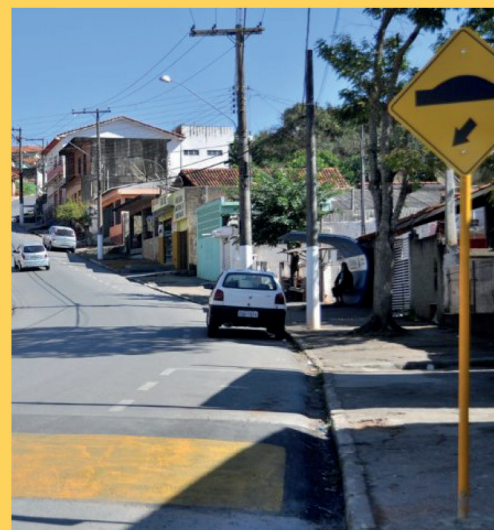
Nova lombada e sinalização na Nove de Julho, no Bairro Miguelzinho
