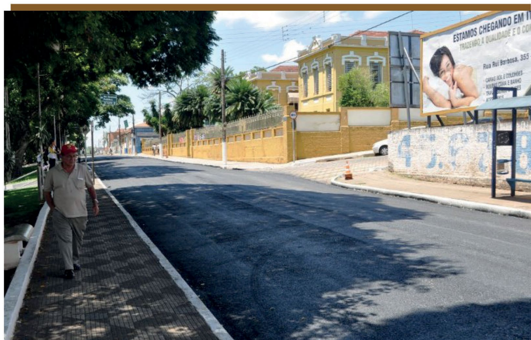
PAVIMENTAÇÃO DA AVENIDA FOI UMA DAS PRIMEIRAS AÇÕES DA ATUAL GESTÃO
