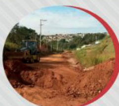
Pavimentação da Avenida Cândido Rodrigues (Vila Isabel)
