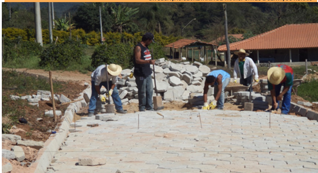
PAVIMENTAÇÃO NO BAIRRO ALTO DA BRANCAL: VIDA NOVA PARA OS MORADORES
