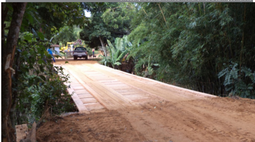
A PONTE DO SALTINHO É UMA DAS 20 PONTES CONSTRUÍDAS DESDE 2013
