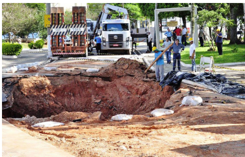
Obras realizadas no Paço Municipal
