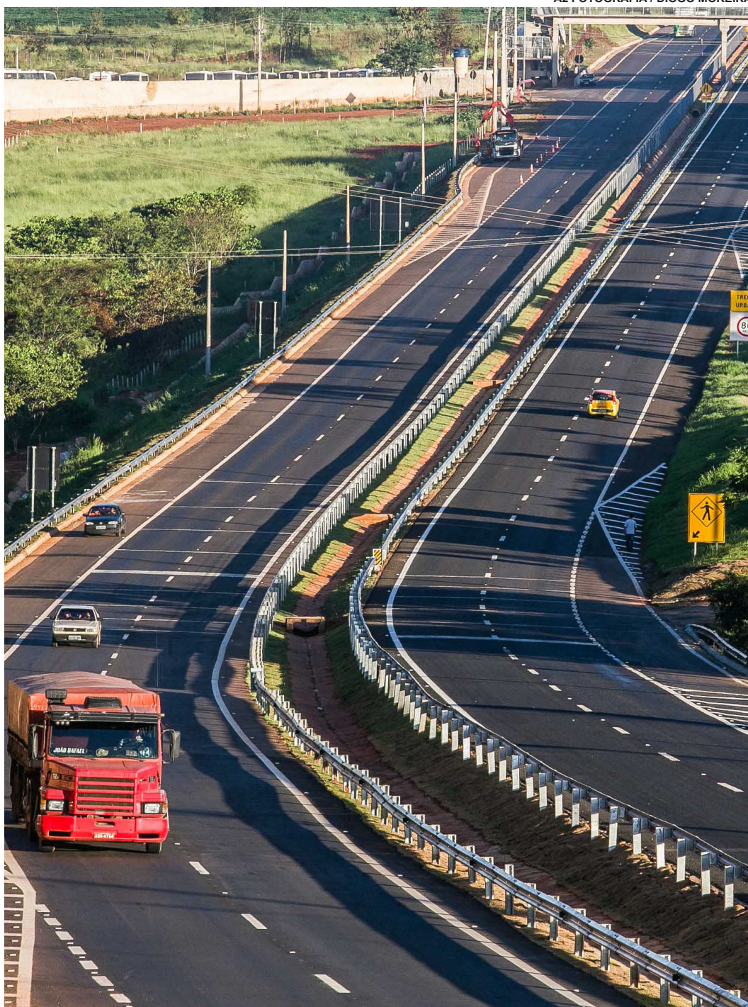
A duplicação abrange dois quilômetros da rodovia, no perímetro urbano de Itapeva
