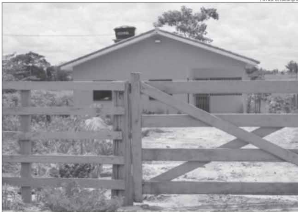
Construção das casas prevê mais infraestrutura para os moradores da zona rural
