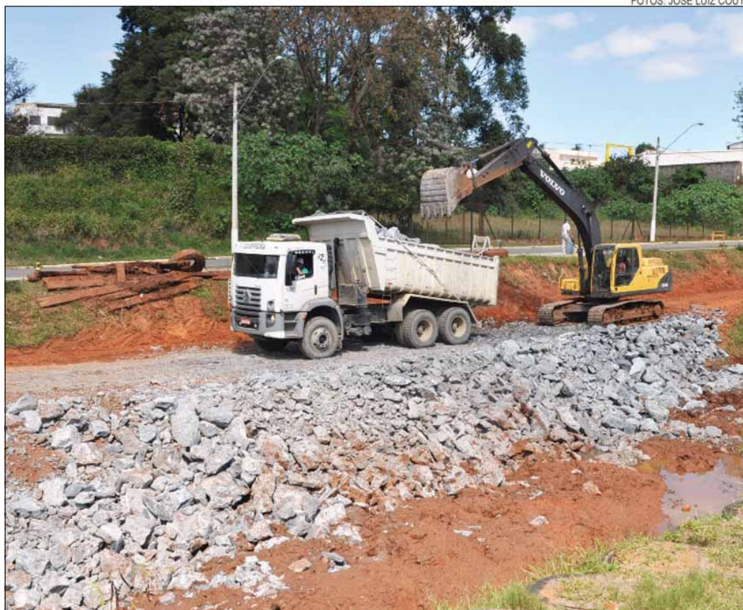
Prefeito conferiu as obras na pista de caminhada da Avenida Mário Covas
