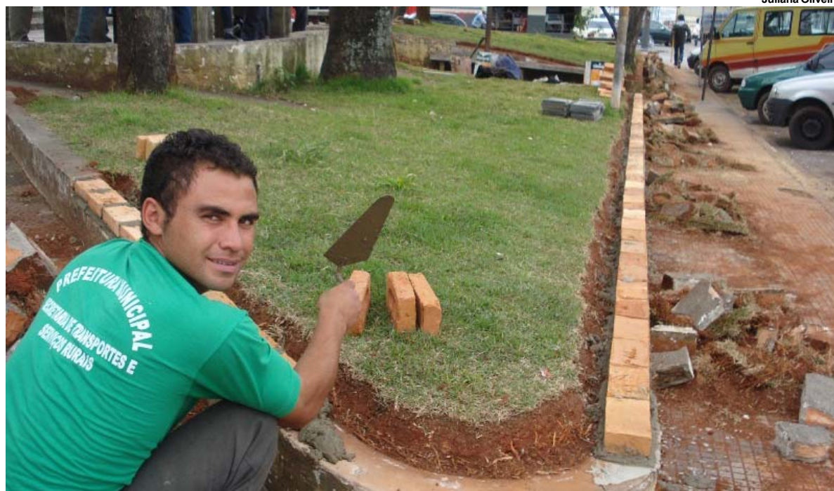
O pedreiro Alessandro Rodrigues em ação pela revitalização da praça que fica no centro da cidade
