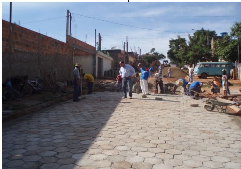
A Frente de Trabalho está pavimentando com lajotas as ruas das Vila Taquari e Parque Cimentolândia.
